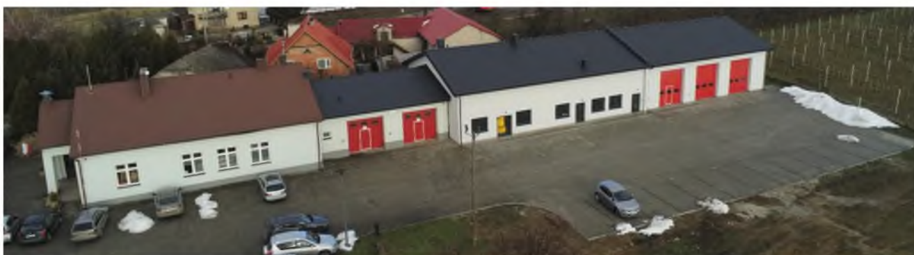
Rozbudowa budynku remizy OSP w msc. Obrazów
