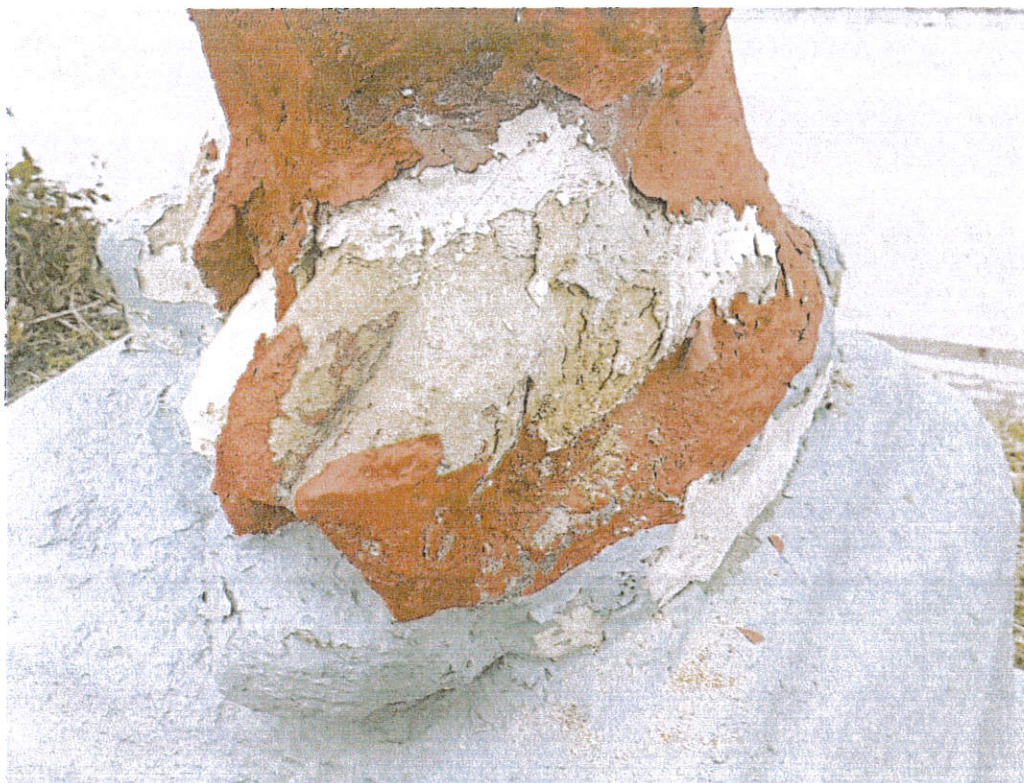
Fot. 4 Kamienna Figura Św. Jana Nepomucena w Obrazowie Stan przed konserwacją – odsłonięta powierzchnia kamienia i warstwy farb Kwiecień 2023 r. wyk. Piotr Zawadzki
